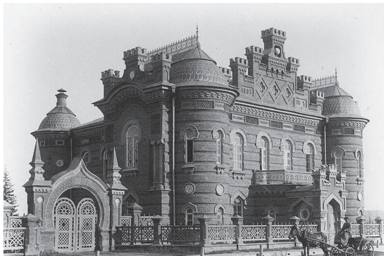
Комплекс зданий ВСОИРГО, Карла Маркса, 2
